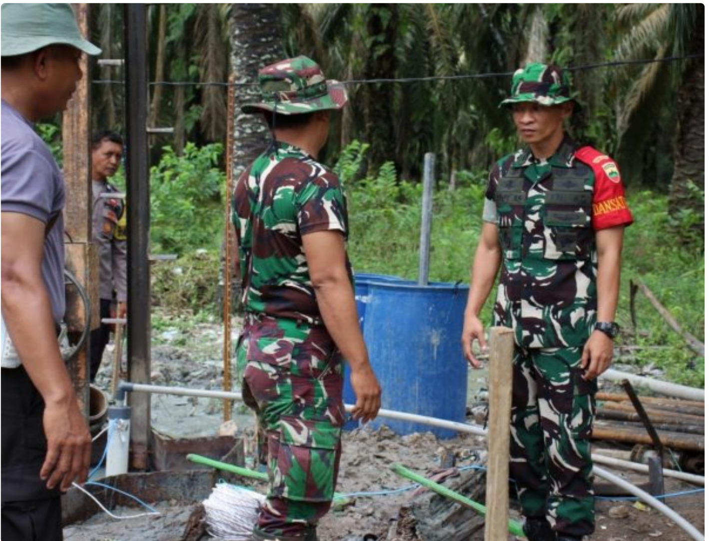
Dansatgas TMMMD ke 120 Kodim 0209/LB Monitoring Pembuatan Sumur Bor di Dusun 2 Desa Selat Beting
